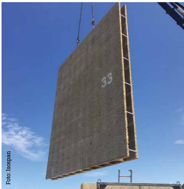
Pareti modulari prefabbricate con sistema a blocchi cassero in legno mineralizzato
