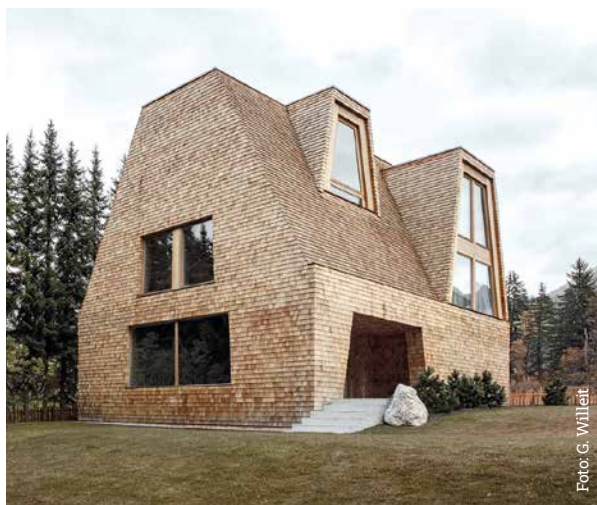
CiAsa Aqua Bad – Pedevilla Architekten
