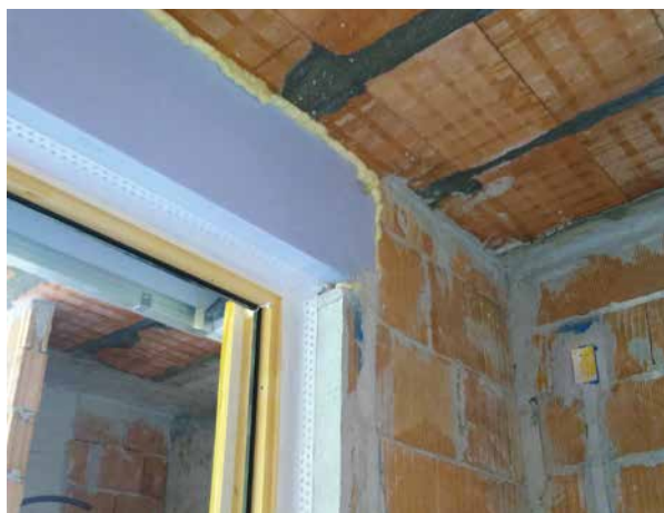
Chiusura sel giunto cassonetto/muratura con schiuma poliuretanic
