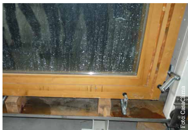
Prove di tenuta all'aria, all'acqua e al carico del vento
