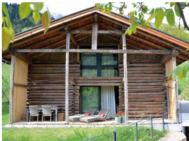
Struttura a Blockhaus di un vecchio maso di montagna in Val Passiria (BZ) certificato CasaClima
