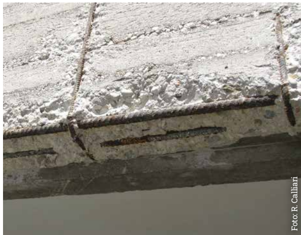
Carbonatazione del calcestruzzo con conseguente ossidazione delle armature ed espulsione del calcestruzzo di copriferro
