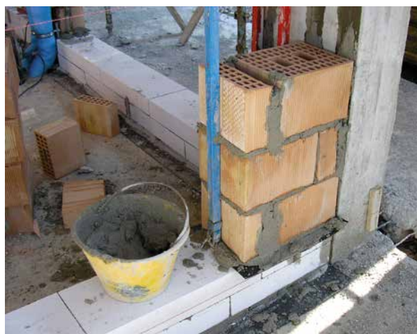
Isolamento sottomuro in corrispondenza del primo solaio
