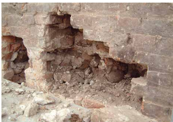
Muratura in mattoni pieni prima di un intervento di ricucitura
