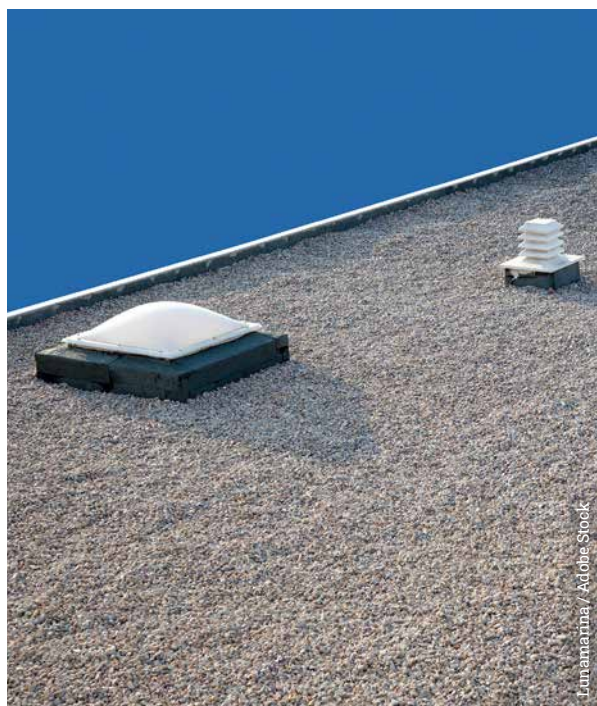
Tetto rovescio ricoperto con ghiaia
