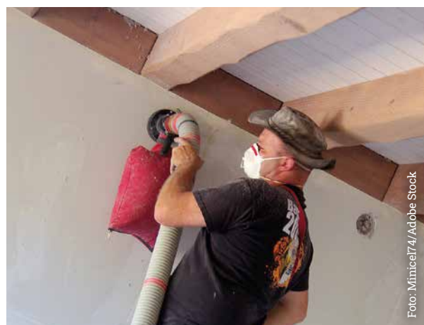
Coibentazione con insufflaggio nell'intercapedine
