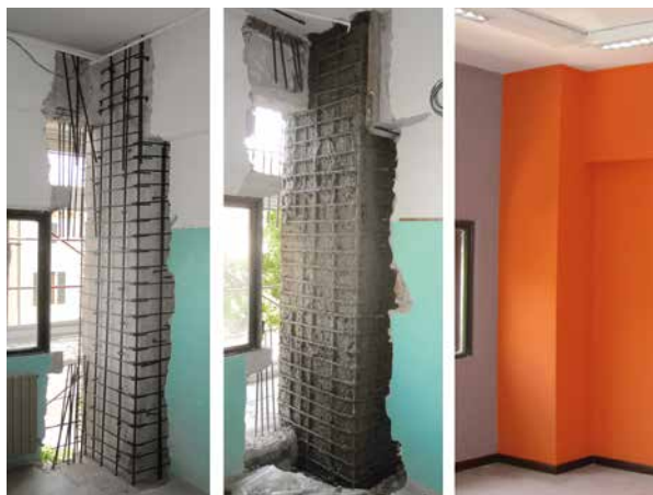
Rinforzo strutturale di un pilastro
