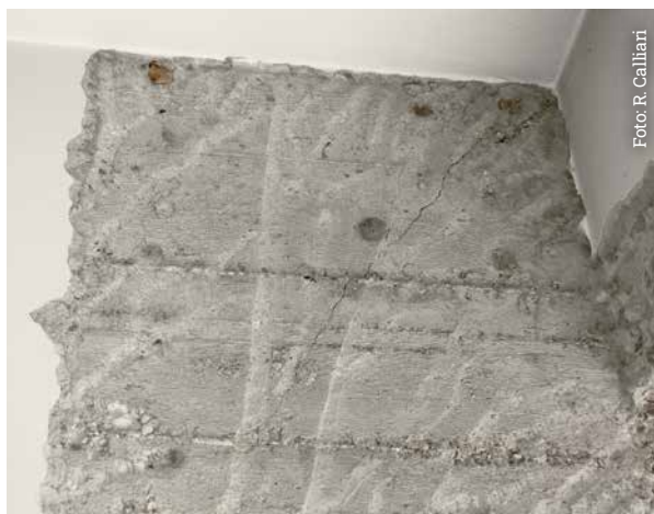
Fessurazione di una trave in altezza in corrispondenza del nodo di connessione con il pilastro. La fessura è determinata da una insufficiente armatura a taglio della trave
