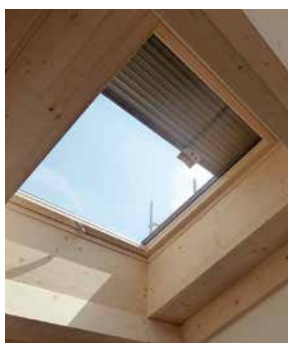
Finestra in falda in legno
