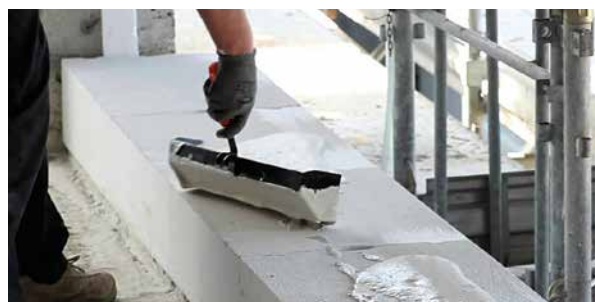
Muratura con blocchi in CAA Ytong
