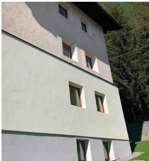
Intervento di risanamento parziale
