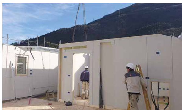
Montaggio di pareti prefabbricate a telaio con cappotto in lana di roccia già posato
