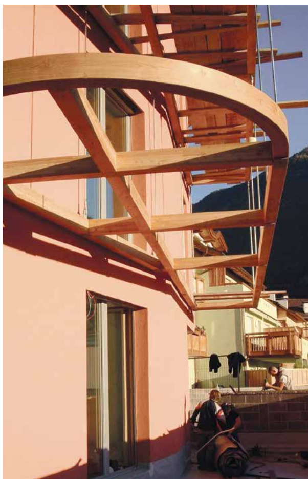
Costruzione di un balcone con struttura esterna
