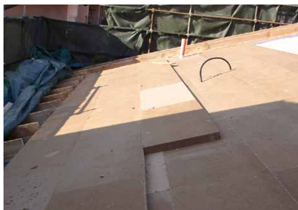
Isolamento sopra i travetti
