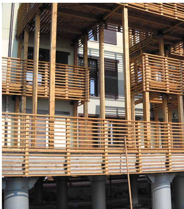
Isolatori sismici tra fondazioni e strutture in elevazione
