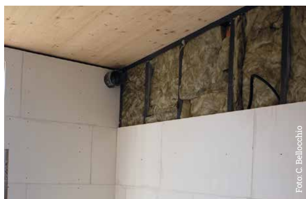
Isolamento contropareti in lana di vetro
