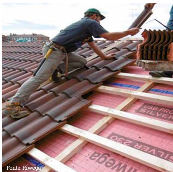
Montaggio delle tegole
