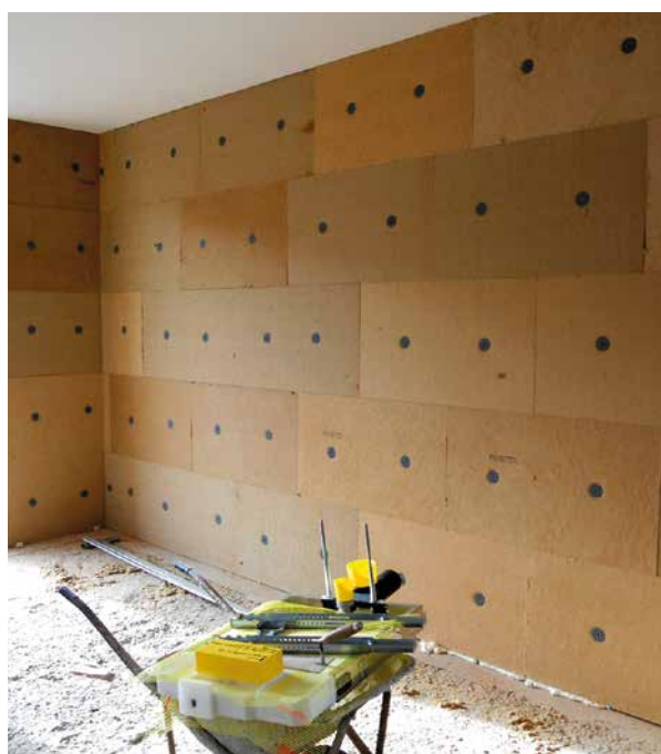
Sistema per cappotto termico interno con pannelli in fibra di legno
