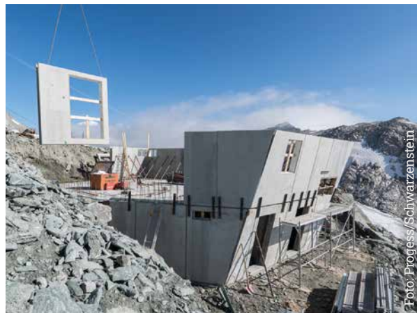
Pareti prefabbricate in stabilimento, composte da due lastre in cemento armato
