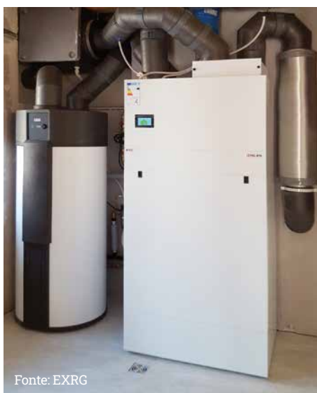
Aggregato compatto con scaldacqua in pompa di calore aggiuntivo
