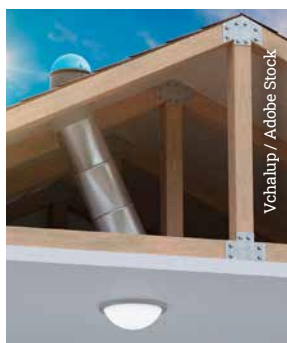
Condotto solare che attraversa il sottotetto
