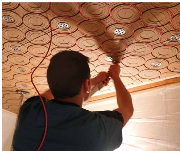
Soffitto radiante
