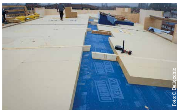
Coibentazione della copertura con fibra di legno
