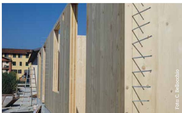
Attacco a terra della struttura in legno
