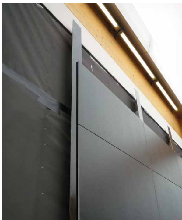
Dettaglio di facciata ventilata
