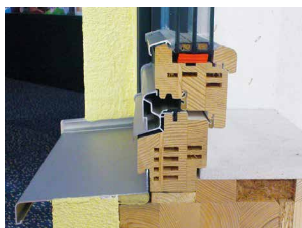
Posa di un infisso in legno
