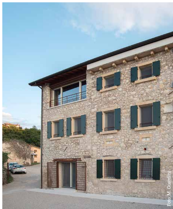
Casa Vaona, Marano di Valpolicella (VR) Ristrutturazione con protocollo CasaClima R
