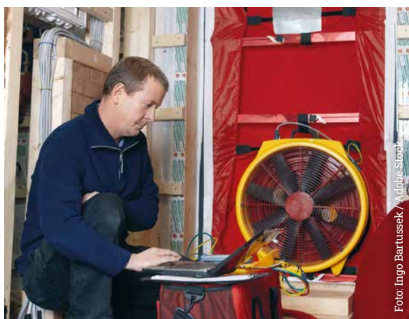
Prova del Blower Door Test per verificare la tenuta all'aria dell'edificio.
