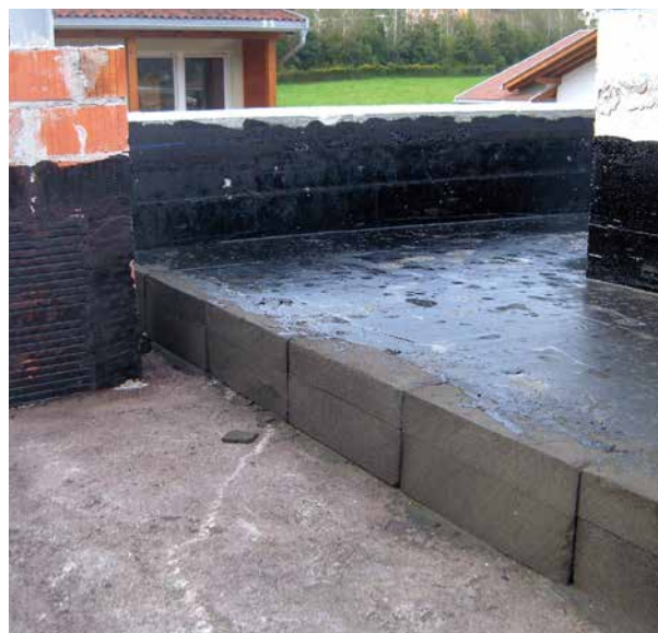
Impermeabilizzazione del tetto e coibentazione con vetro cellulare
