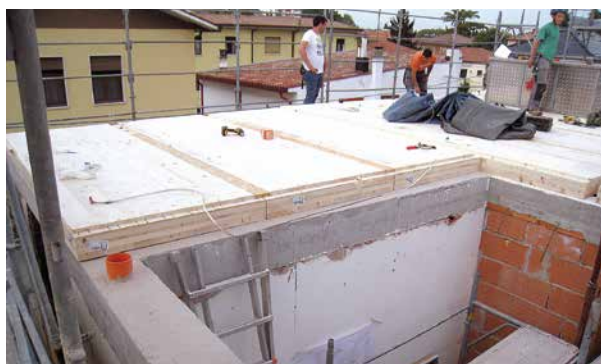
Intervento di ristrutturazione con sopraelevazione in legno
