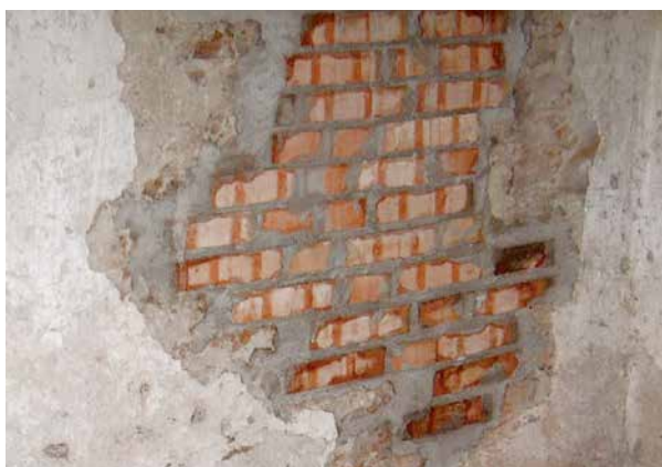
Muratura in mattoni pieni su cui è stata eseguita la tecnica dello scuci-cuci per ricostituire l'integrità strutturale
