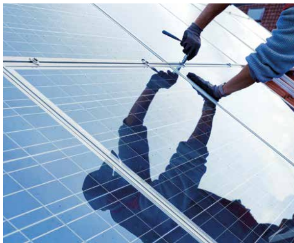
Copertura a falde con integrati i pannelli fotovoltaici
