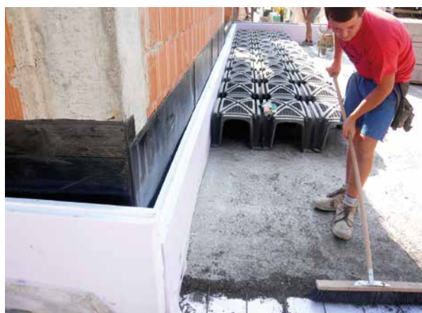
Impermeabilizzazione del muro perimetrale
