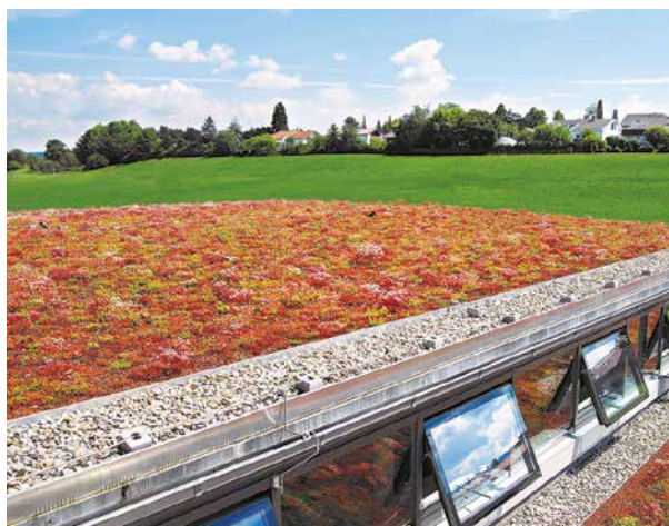
Tetto verde estensivo
