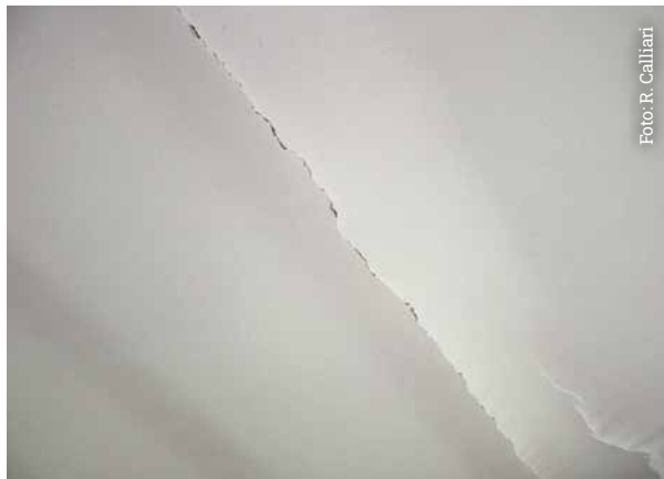
Sfondellamento di solaio prima di aver rimosso l'intonaco fessurato
