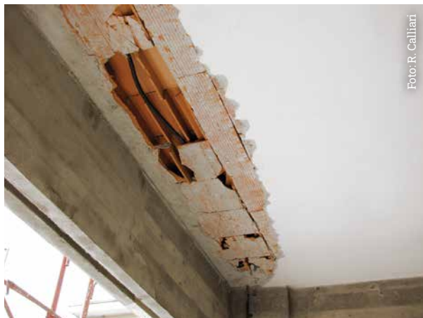
Sfondellamento di solaio dopo aver rimosso l'intonaco fessurato
