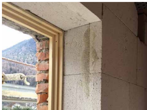
Isolamento interno in lastre di calcio silicato
