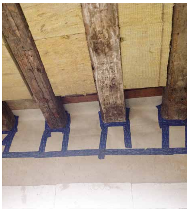
Isolamento interno ai travetti
