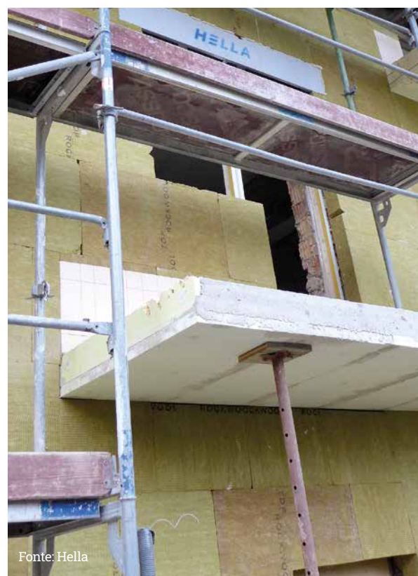
Coibentazione del balcone
