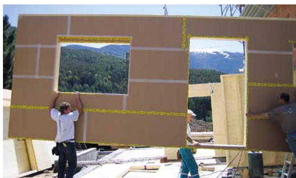
Posizionamento di una parete a telaio in legno coibentata con isolamento insufflato in cantiere
