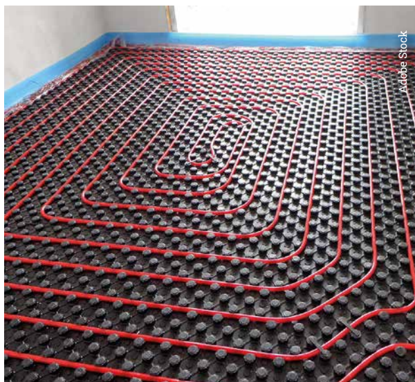
Pavimento radiante
