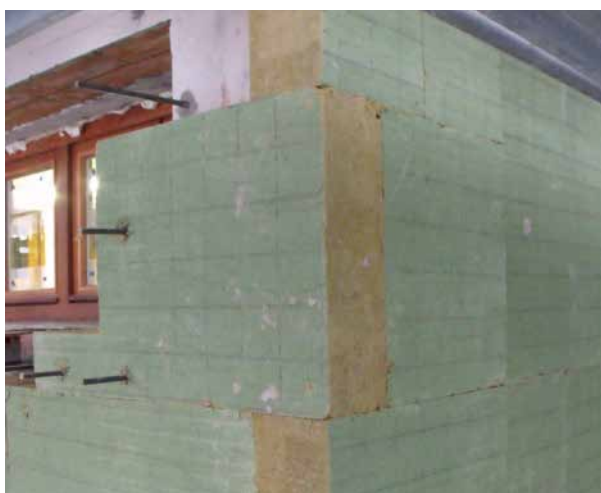
Isolamento a cappotto in lana di roccia
