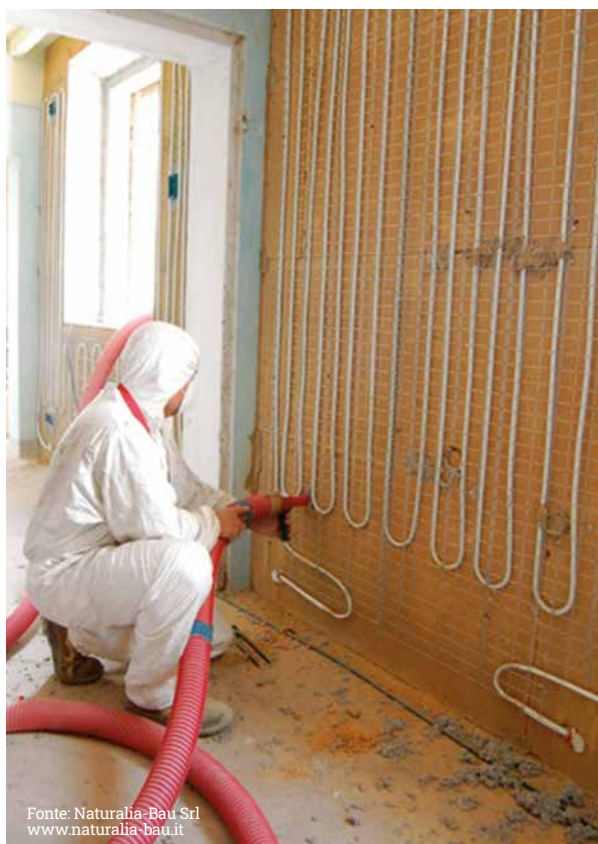
Tecnica di insuflaggio con cellulosa
