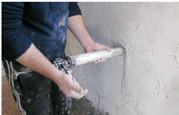
Rinforzo di muratura in pietra mediante iniezione di malta di calce
