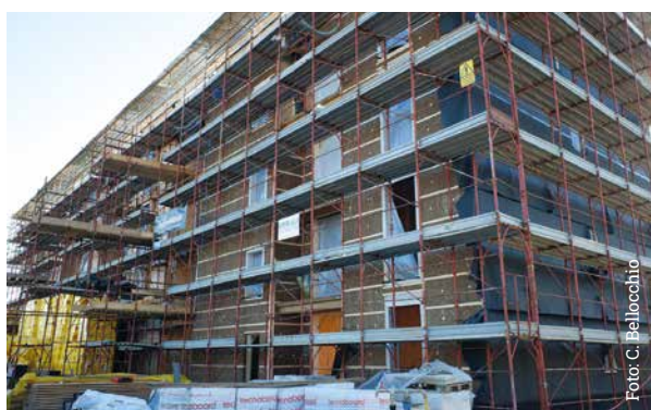
Isolamento involucro in lana di roccia
