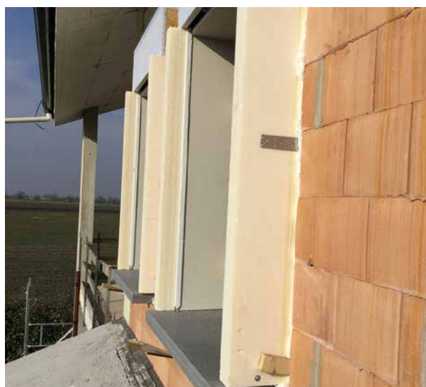
Coibentazione delle spallette delle finestre in un'nuova costruzione
