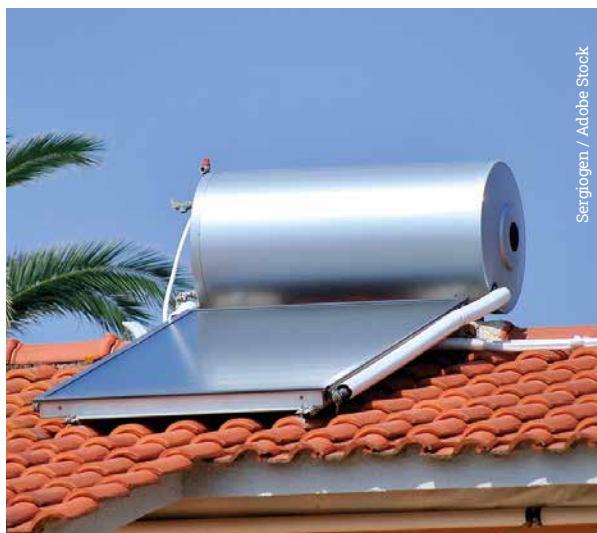
Sistema a circolazione naturale senza l'ausilio di pompa di circolazione
