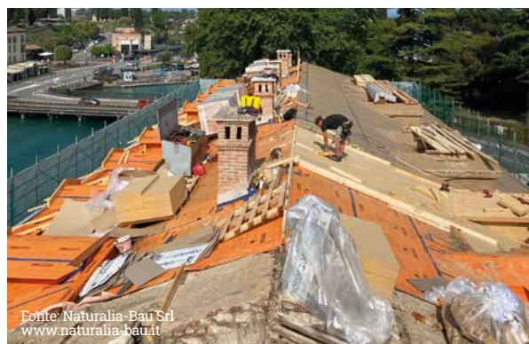
Coibentazione copertura in fibra di legno
