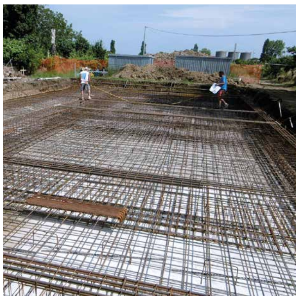
Coibentazione delle fondazioni con XPS
