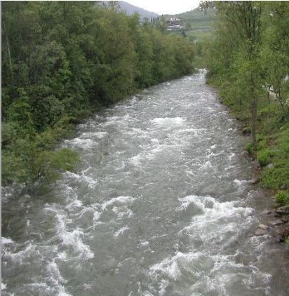
Ausgleichsbecken zur Reduzierung von Sunk und Schwall – weitere Studien auf anderen Schwallstrecken laufen
