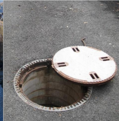
Maßnahmen im Abwasserbereich - Kläranlagen und Kanalisationen
