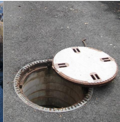
Maßnahmen im Abwasserbereich - Kläranlagen und Kanalisationen
