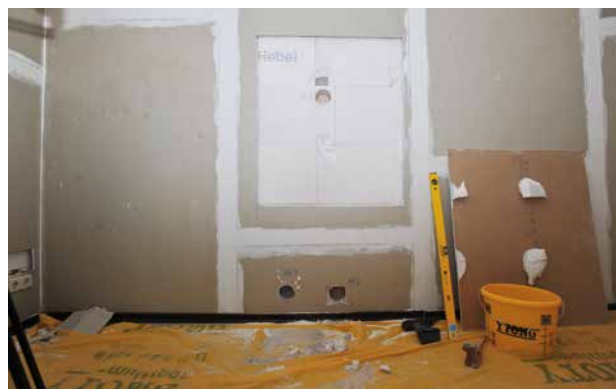
Fig. 2: Ispezione della parete nel soggiorno (Finsterwalde, Germania). Parete prima (in alto) e dopo l'apertura e la rimozione delle carote di perforazione (in basso). La carta da parati di finitura era già stata rimossa in precedenza.
