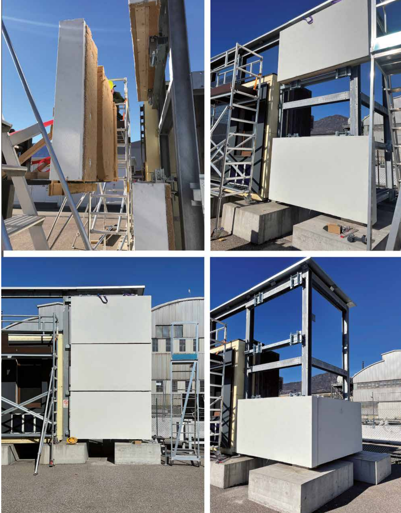
Figura 6 Test funzionali dei sistemi di ancoraggio e dell'installazione/smontaggio dei pannelli
