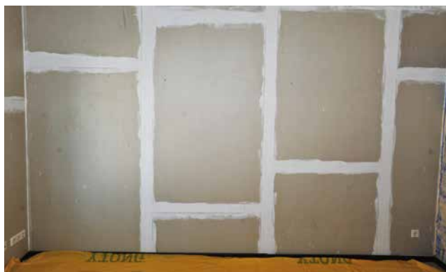
Fig. 2: Ispezione della parete nel soggiorno (Finsterwalde, Germania). Parete prima (in alto) e dopo l'apertura e la rimozione delle carote di perforazione (in basso). La carta da parati di finitura era già stata rimossa in precedenza.
