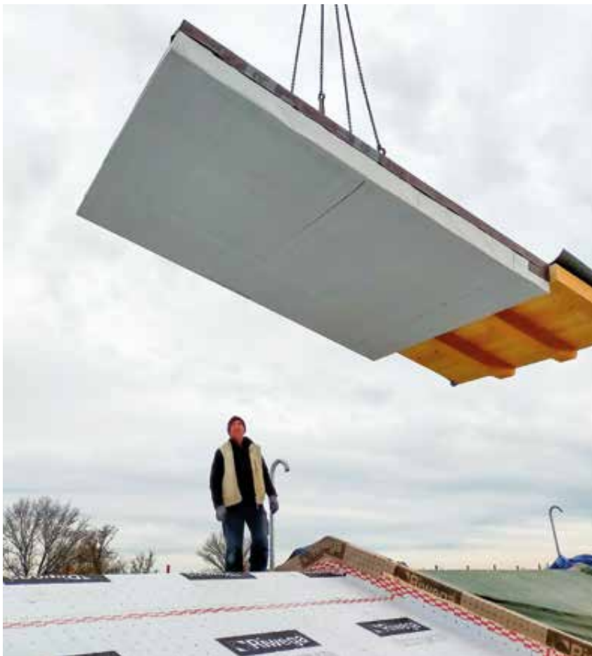
Arrivo in cantiere degli elementi in Xlam pre-tagliati in fabbrica
