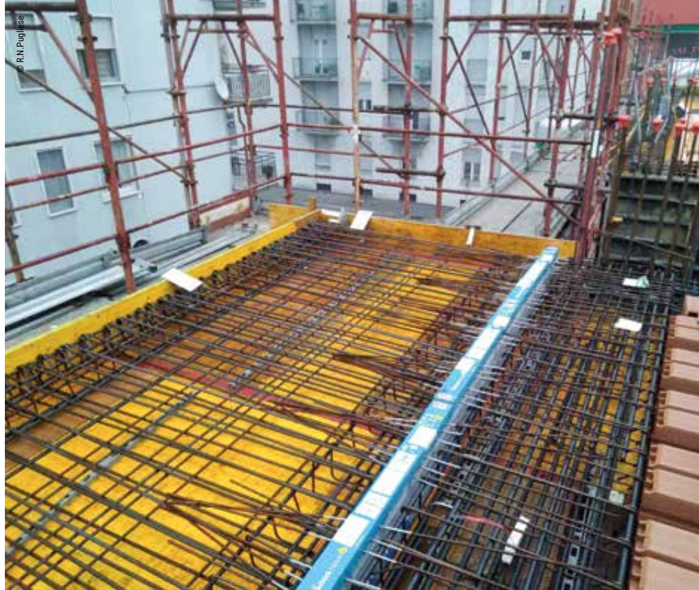
Dettaglio del taglio termico del balcone
