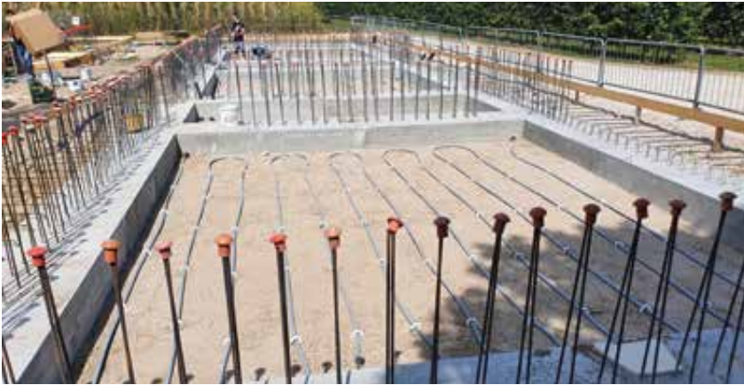
Fondazioni con inseriti tubi per il pre-temperamento geotermico
