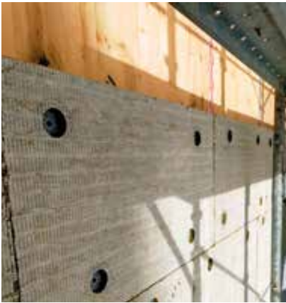
Coibentazione con fibra di legno
