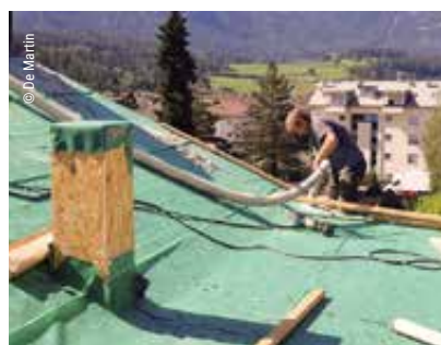
Risanamento di un tetto con insufflaggio
