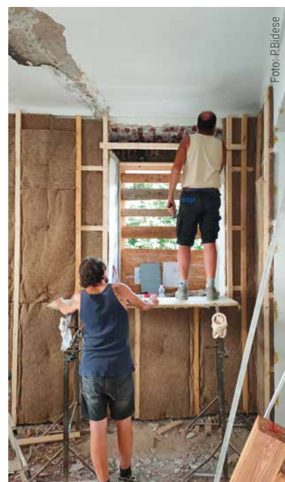
Pareti isolate con fibra di canapa
